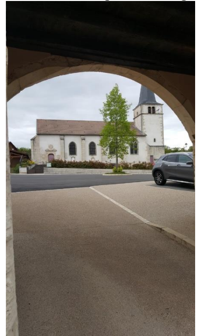
Finition des travaux place de l'Eglise
